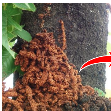
大量に排出された フラス
